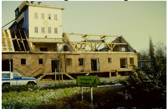
Der Abbruch hat begonnen
